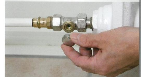
Prüfen der Voreinstellung an einer Rücklaufverschraubung
